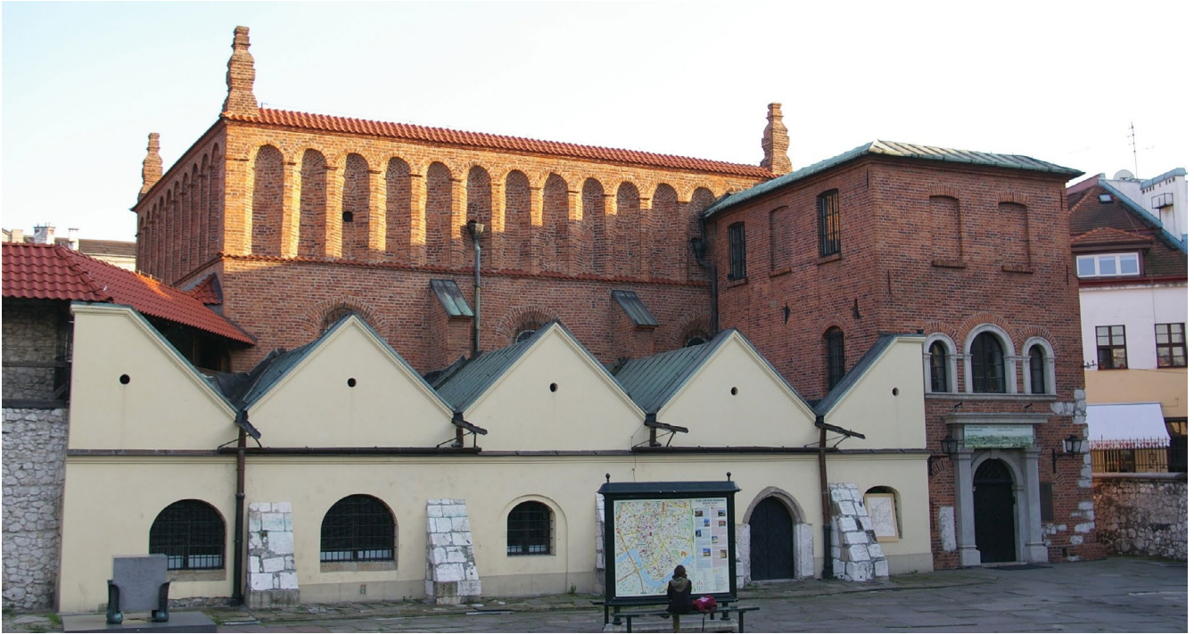
Alte Synagoge in Kazimierz, Außenansicht, Krakau 2014.
